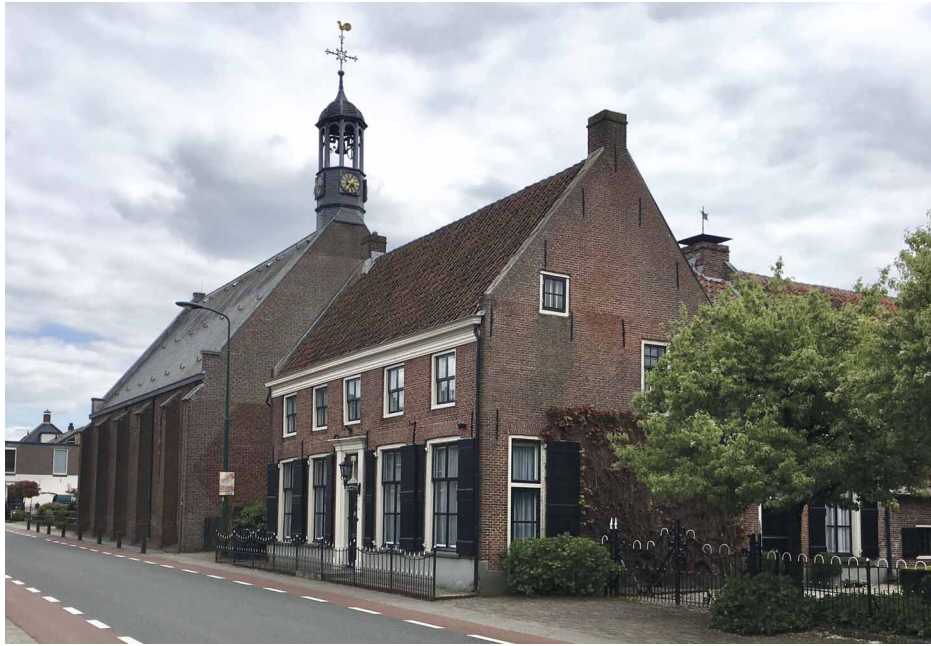
Een gelijkend pand zoals de pastorie aan de andere kant van de kerk. Dit woonhuis is jarenlang bewoond geweest door Mies Bouwman.
