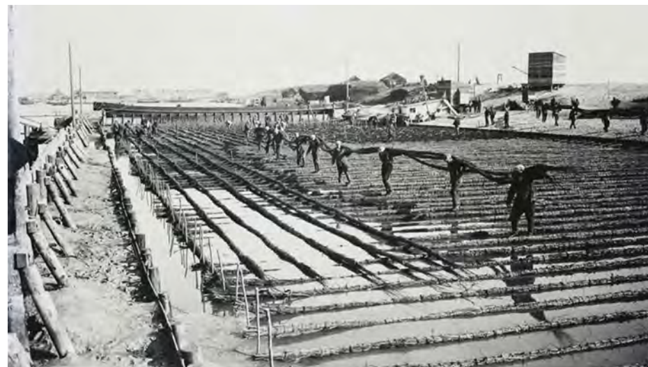
Op de foto zijn werklieden bezig met het neerleggen van een bundel rijshout ("wiep"). Boven op de dijk een houten bouwsel zoals Van Vlijmen dat ook afbeeldde.
