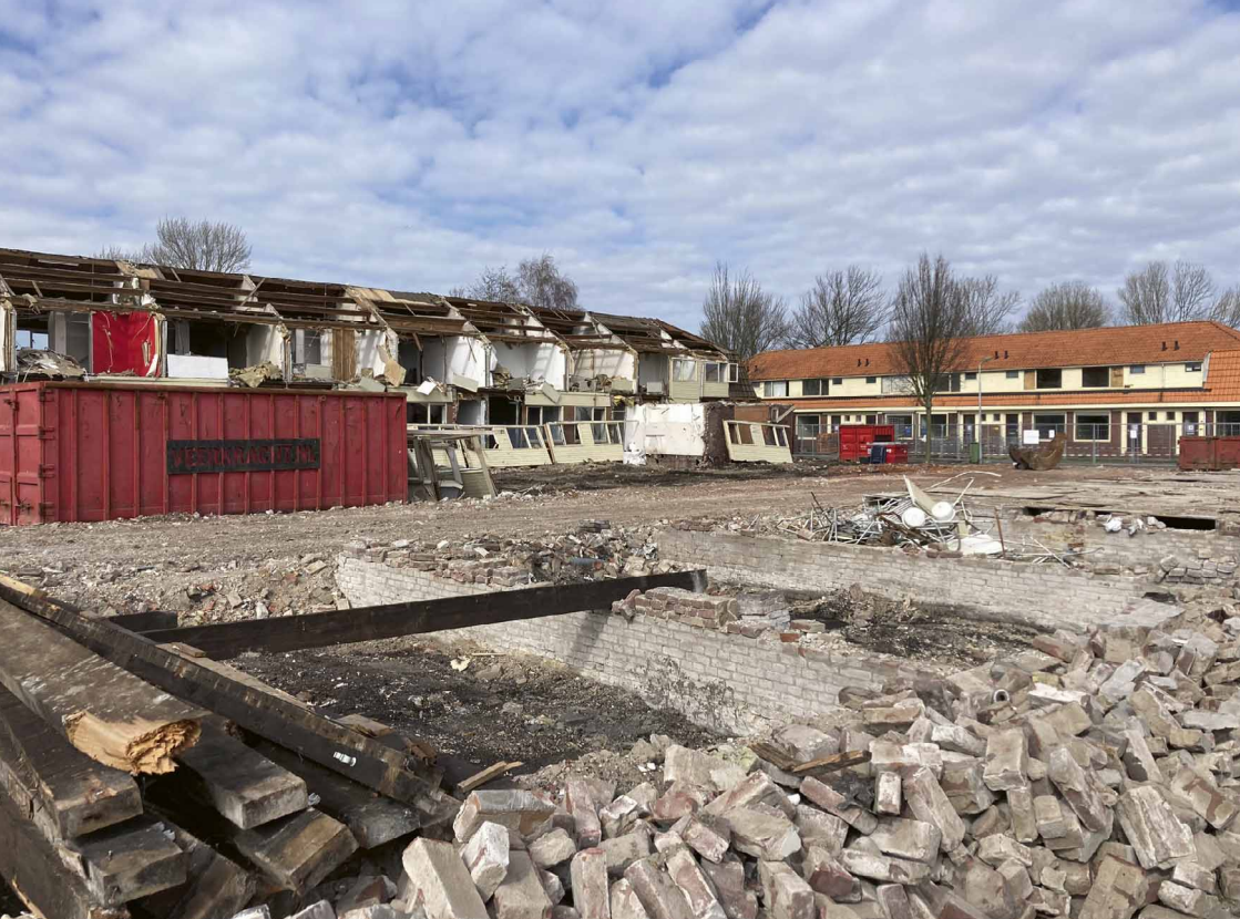
Sloop woningen aan de Slachthuisstraat, Zaandam
